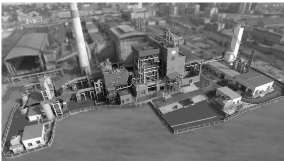
图8 应城 35 MW th 富氧燃烧工业性示范工程全景
