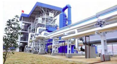
图9 3 MW(th)全流程富氧燃烧碳捕获试验系统(武汉)
